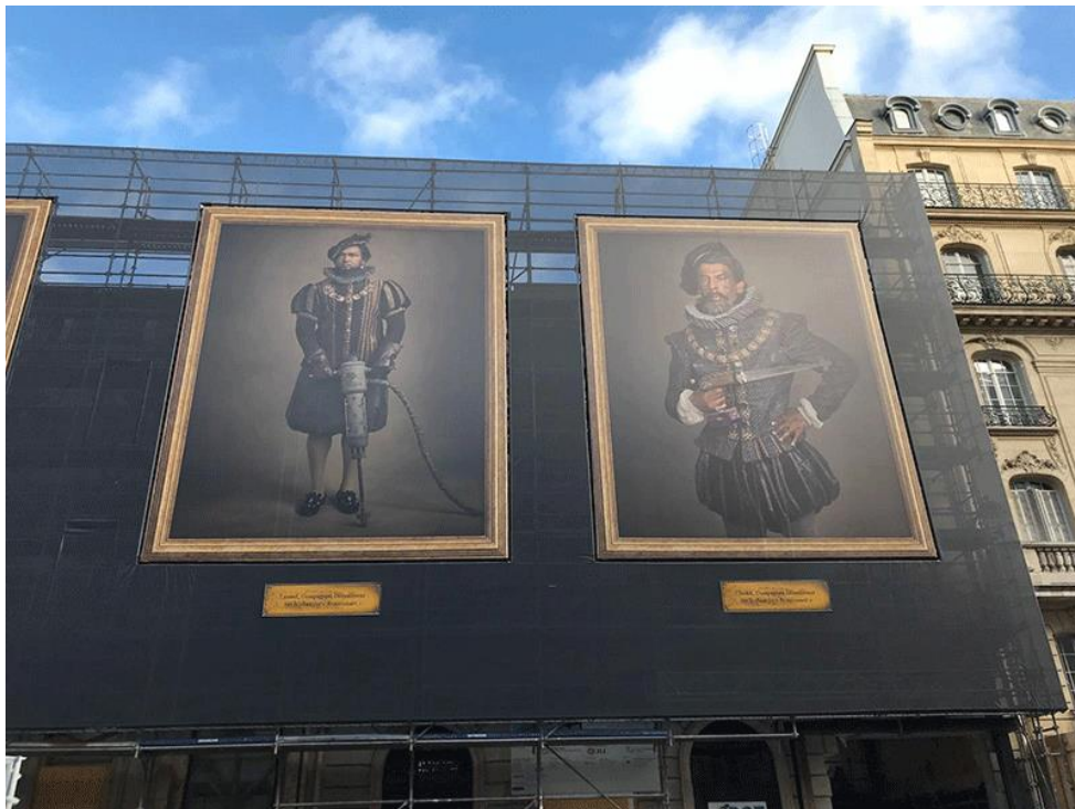
L'échaffaudage rue François 1er.
